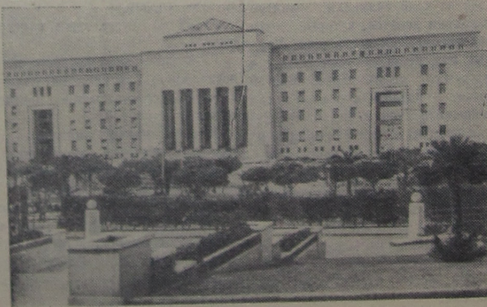
Объединенная Арабская Республика (Египетский район). На снимке: здание инженерного факультета Александрийского университета. Фото Управления информации Египетского района ОАР.
