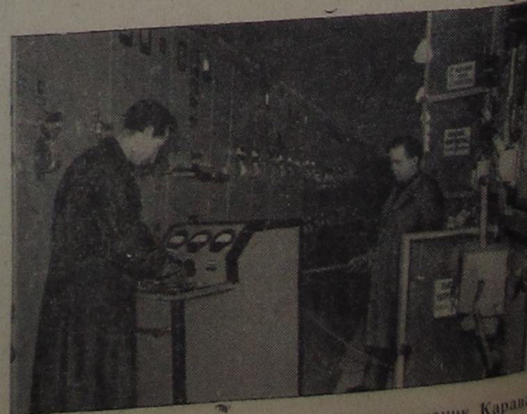
Инженер Богач В. А. (слева) и старший механик Караваев Г. К. испытывают кабель кенотроном. Фото П. Зольникова.
