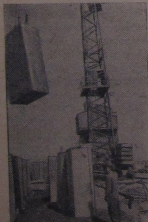
Караганда. Местные инженеры в содружестве с работниками научно-исследовательского института строительных конструкций Академии строительства и архитектуры СССР нашли способ применить в строительной технике горелые породы, которые до сих пор не использовались. Разработана конструкция кирпично-бетонных блоков и панелей, сделанных из крупнопористого бетона и горелых пород.
