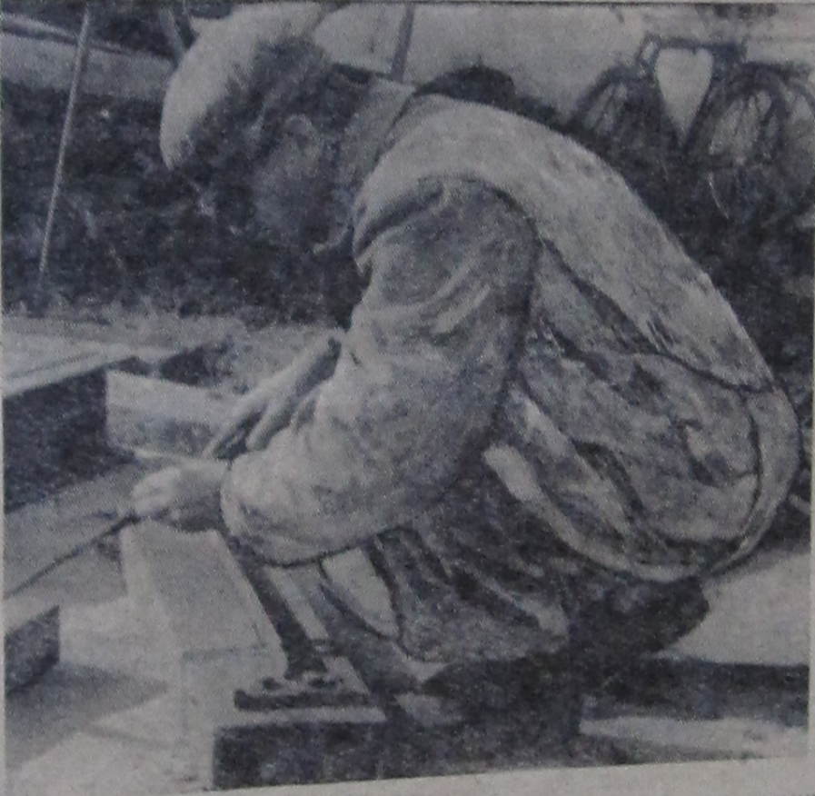
П. В. Rogozin с честью носит высокое звание ударника коммунистического труда. В летний период он проработал большую работу по ремонту теплотрассы. Свои трудовые успехи Петр Владимирович посвящает XXII съезду КПСС. На снимке: лучший сварщик отдела главного энергетика Института П. В. Rogozin. Фото И. Чувствана.
