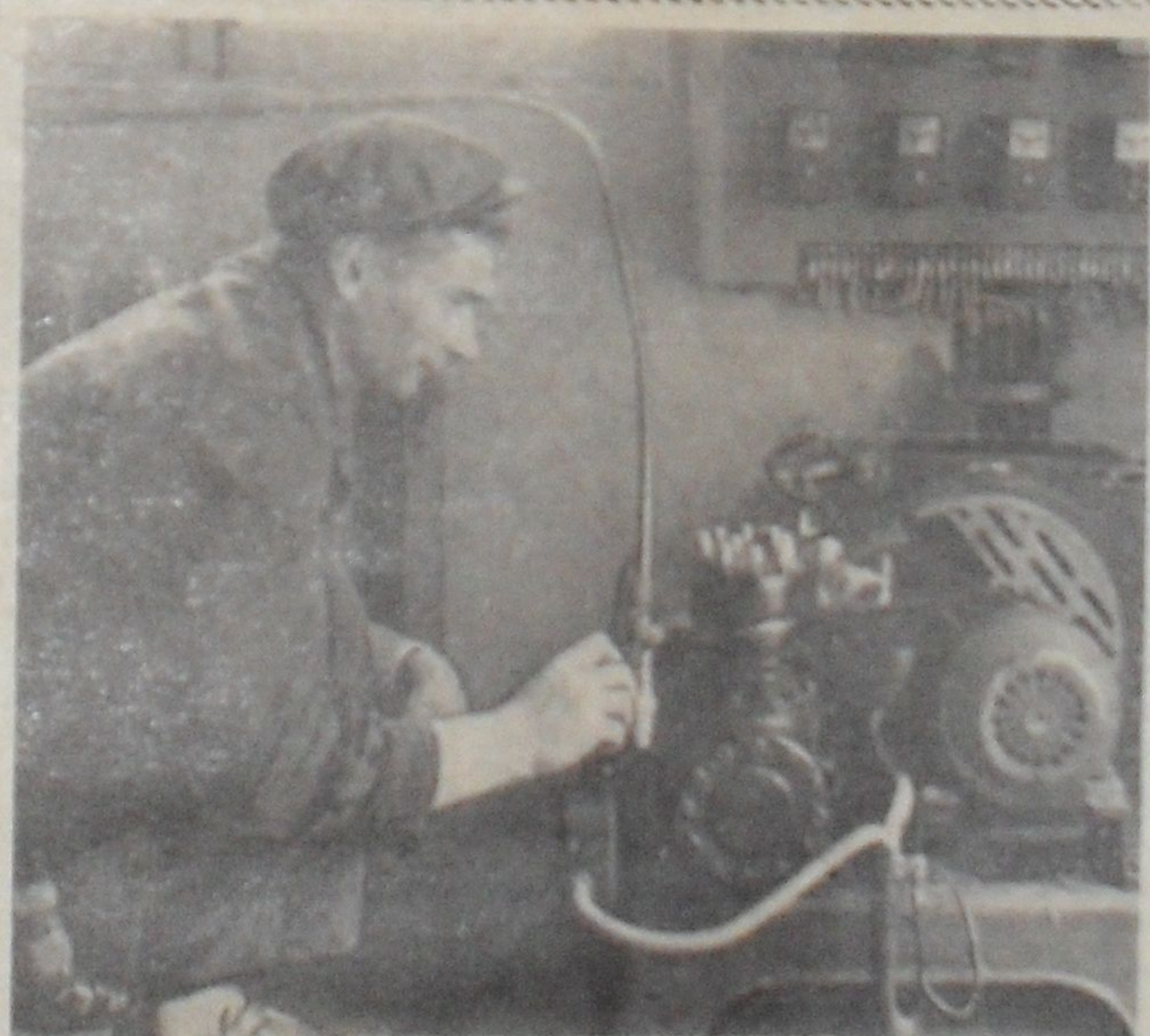
Поддержание нужной температуры в холодильных установках — важное технологическое требование в работе азотного завода. И здесь все большее усовершенствование вносит заводские рационализаторы. На снимке: механик В. Д. ИВАНОВ у автоматического регулятора температуры, в усовершенствование которого он внес свой вклад. Фото В. Шустова.
