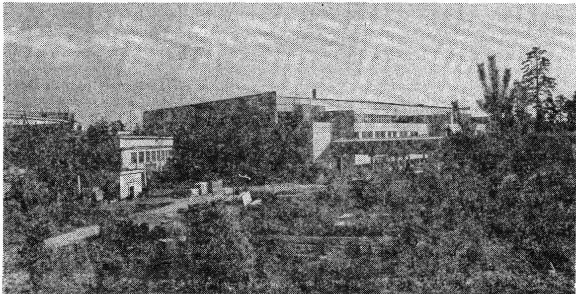
Один из важнейших объектов капитального строительства — здание 205 Лаборатории высоких энергий.
