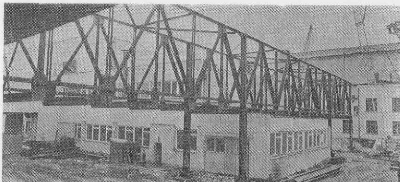
В Лаборатории ядерных реакций ведутся работы по сооружению циклотронного комплекса У-400 и У-400М. Ускоритель У-400 соединит со второй ступенью ускорительного комплекса — реконструированным циклотроном У-300 — канал для транспортировки пучков, проведенный в специальной галерее. Сейчас монтируются металлоконструкции галереи. Фото Ю. ТУМАНОВА.
