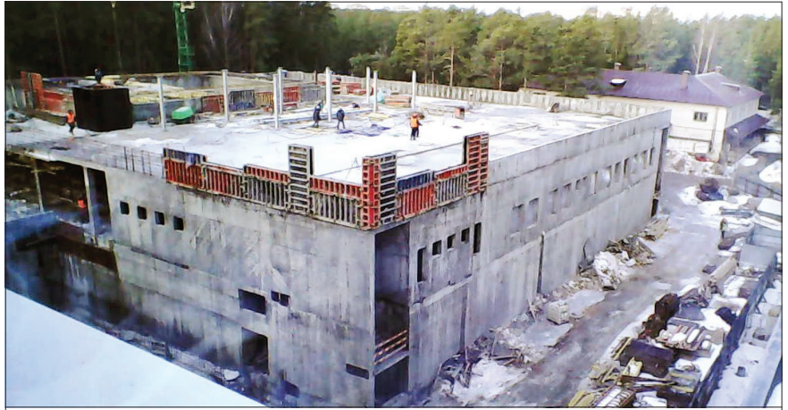
Фото здания ДЦ-280 с телекамеры монитора; 2 февраля 2016 г., 9.00.
