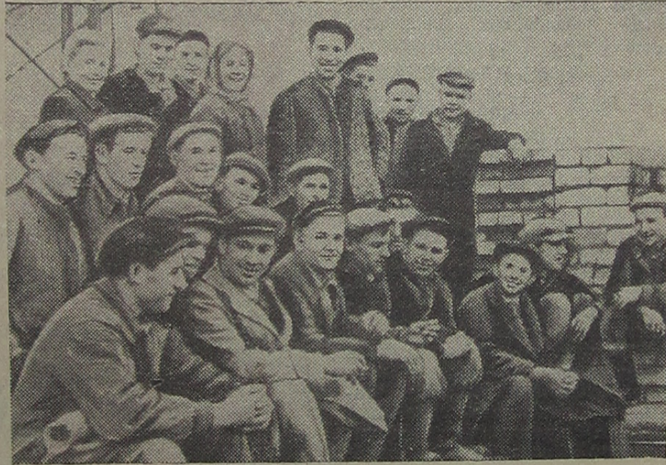
Тот, кто не был в нашем городе месяц, не узнает квартала № 3, что расположен на Комсомольской улице. За этот короткий срок здесь вырос новый жилой четырехэтажный дом, на другом доме ведется кладка стен второго этажа. Это результат упорного труда коллектива хозрасчетной комплексной бригады инженера В. В. Семевского.
