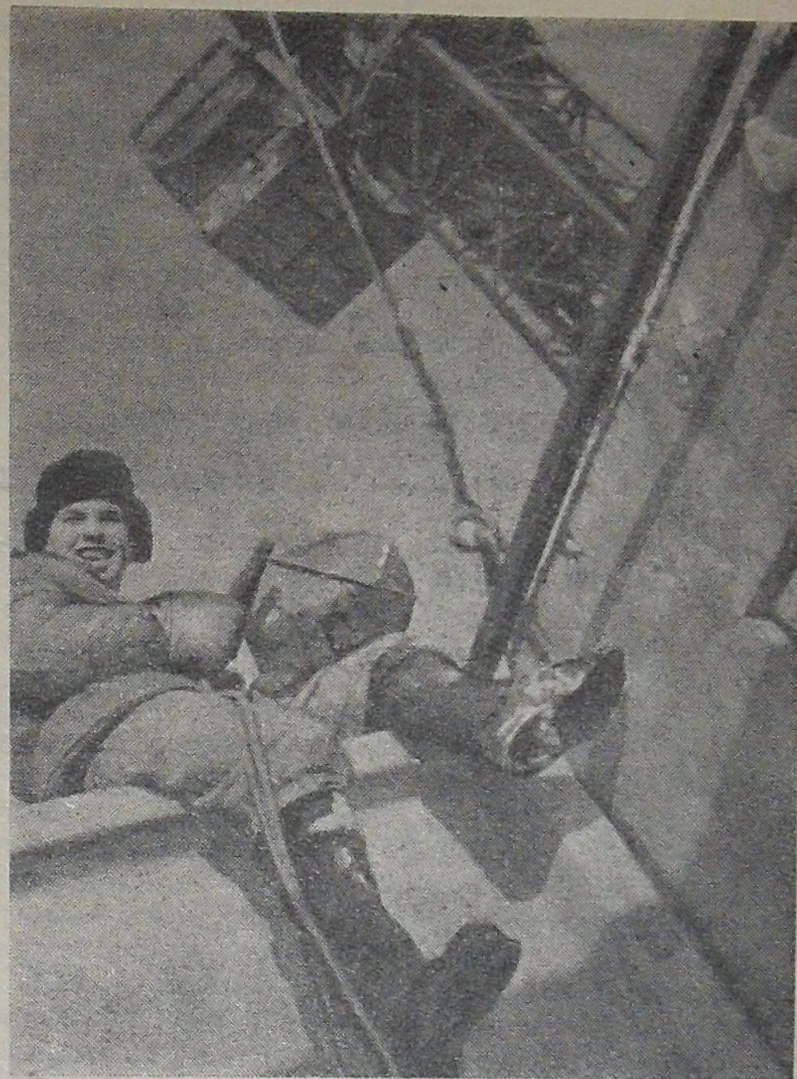
Высоко, на пятый этаж вышли монтажники бригады Бориса Архипова. Еще на днях ставились панели перегородок, а сегодня бригада заканчивает перекрытие четвертого этажа. К новому году будет собран еще один пятиэтажный дом на Большой Волге.
