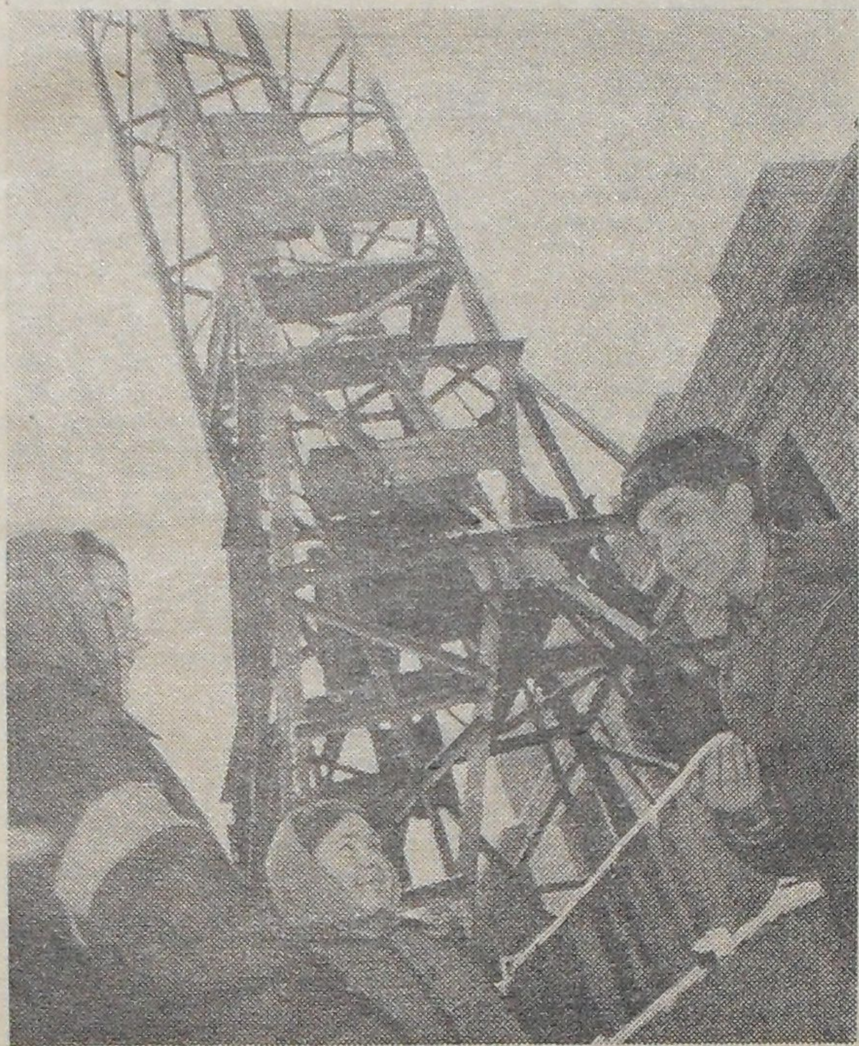
На снимке: инженер по охране труда и технике безопасности Г. И. СИЛКИН на рабочем месте дает инструктаж строителям. Фото Ю. Туманова.
