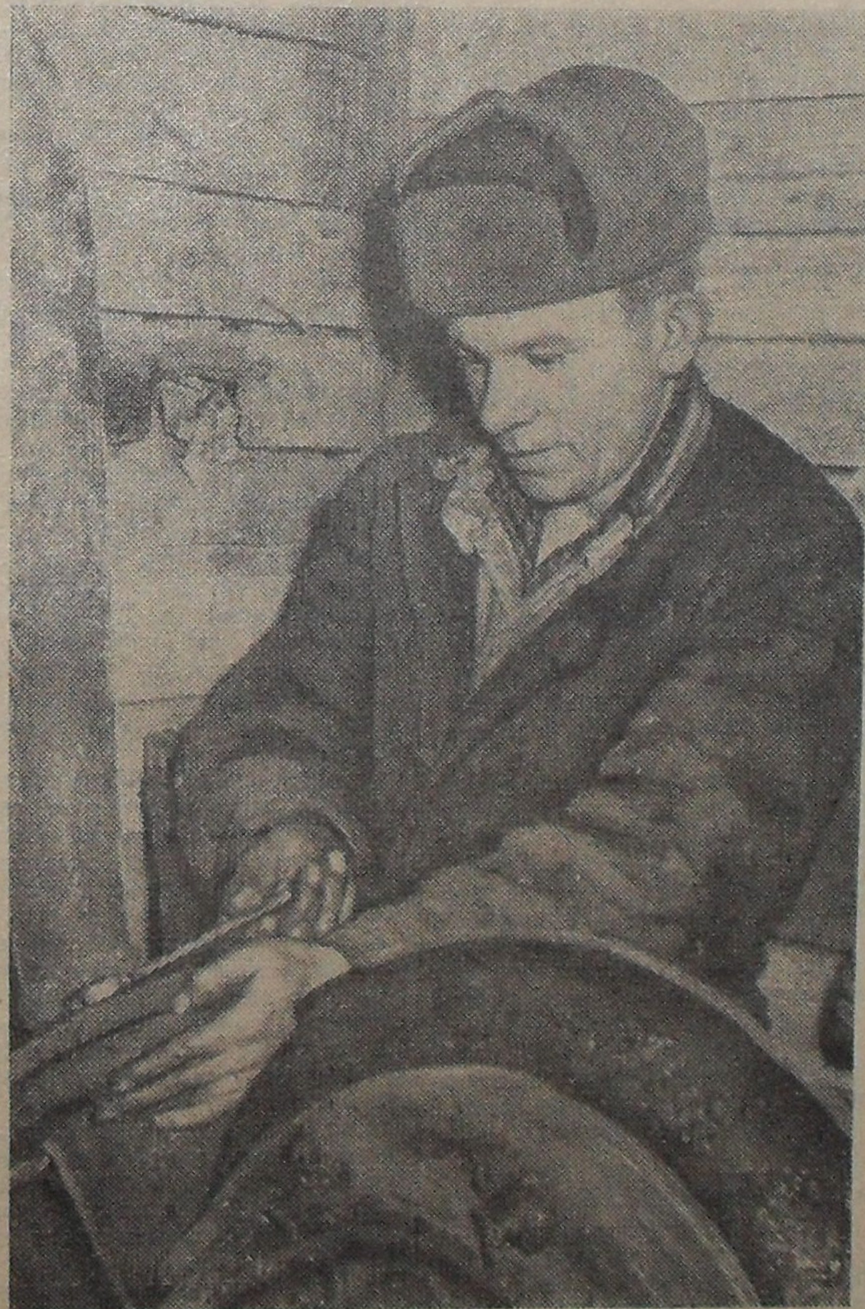
АЛЕКСАНДРОВ Василий Сергеевич — слесарь растворо-бетонного цеха завода железобетонных изделий. Более 4-х лет он работает на заводе. В. С. Александров обеспечивает срочный ремонт и бесперебойную работу механизмов бетонного цеха. Бригада, в которой он работает, выполняет нормы выработки на 120—130%. Своей исключительно добросовестной работой тов. Александров вносит немалый вклад в общий показатель бригады по приготовлению бетона, которая в I—IV кварталах 1964 года завоевывала первое место в соревновании среди бригад цеха. Два года тому назад тов. Александрову присвоено звание ударника коммунистического труда. Он занесен на заводскую Доску почета. Фото Н. Печенова.
