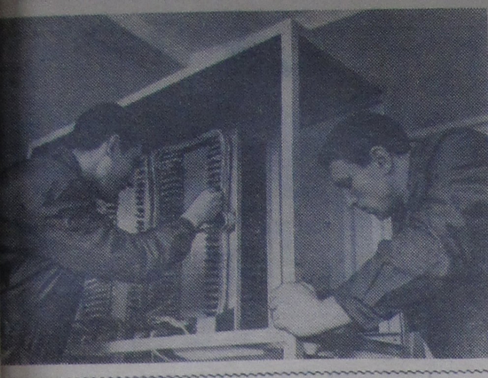
В отделе новых ускорителей, в группе Ю. Н. Денисова, ведутся работы по созданию комплекса электронного оборудования для измерения характеристик магнитного поля релятивистского циклотрона. Решение задачи создания необходимой топографии весьма неоднородного магнитного поля ускорителя этого типа требует большого объема вычислительных работ по гармоническому анализу сложной зависимости магнитного поля от радиуса и азимута. Эти вычисления будут вестись на специализированной вычислительной машине, разработанной в отделе новых ускорителей ЛЯП. На снимке: инженеры В. Н. АНОСОВ (справа) и В. И. ПРИЛИПКО за наладкой цифрового анализатора гармоник.
