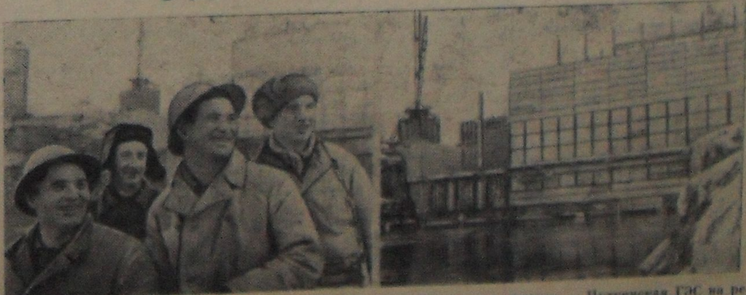
Карельская АССР. Близится пуск головной на Кемском каскаде Путькинской ГЭС. Первый агрегат ее уже работает на холостых оборотах. Путькинская ГЭС мощностью 84 тысячи киловатт — первая на пяти гидроэлектростанций каскада на реке Кемь. Ввод ее в эксплуатацию будет подарком Родине к 50-летию Великого Октября.
