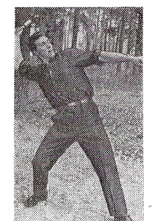
«Золотой» взмах радиомонтажника Ю. Аверьянова.
