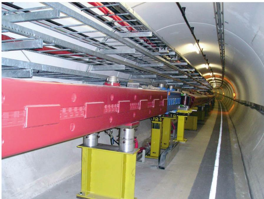
Фото 8. Дипольные магниты в тоннеле каналов транспортировки пучка
