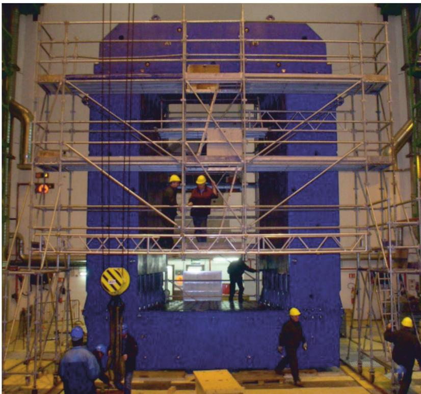
Фото 17. Ярмо магнита димюонного спектрометра. Спроектировано в ОИЯИ
