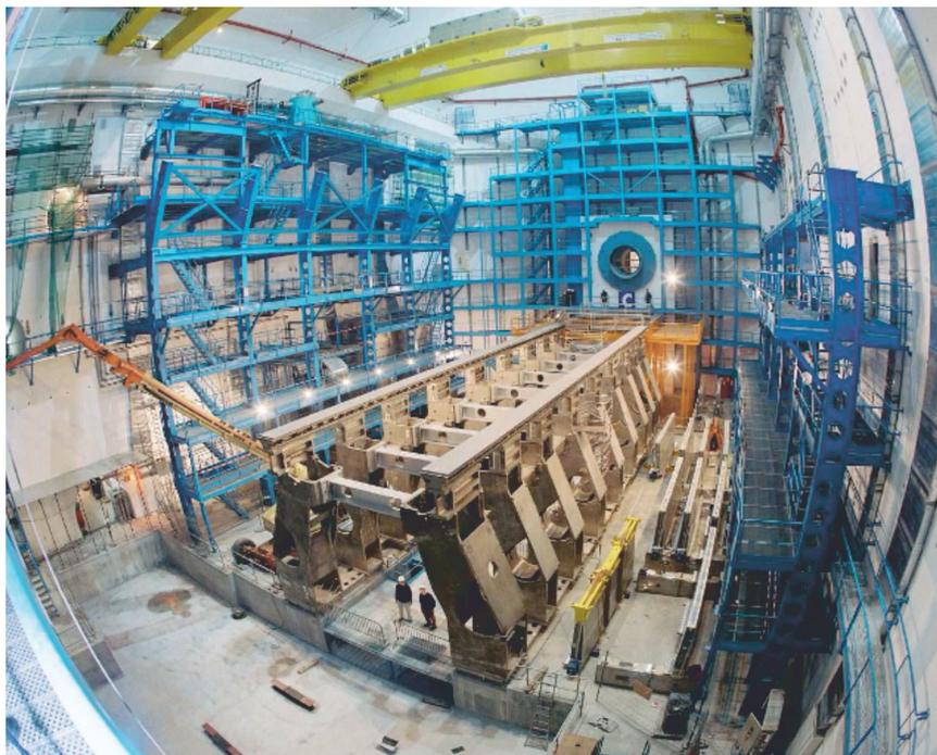
Фото 14. Монтаж базовых опор в подземном зале эксперимента ATLAS
