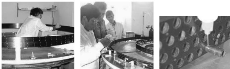
Рис. 20. Слева направо: установка пинов заземления внешнего кольца, установка строу в кольца и вклейка строу пневмодозатором
