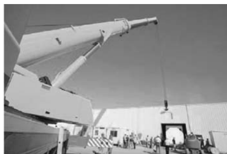
Рис. 34. Перенос детектора к входу в шахту
