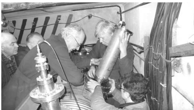
Рис. 4.5. Установка умножающей колонны на ввод ЭСС на криостате нуклотрона
