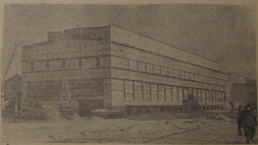
ВОЛОГОДСКАЯ ОБЛАСТЬ. Строители Череповецкого металлургического завода одержали новую трудовую победу — закончили сооружение мощного обжимного стана — блюминга.
