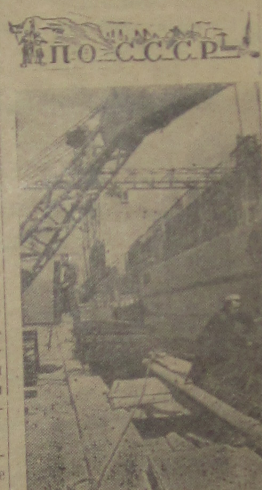
Строительство Воронежской атомной электростанции. Монтаж арматуры. Фото А. Зенина. ФОТОХРОНИКА ТАСС
