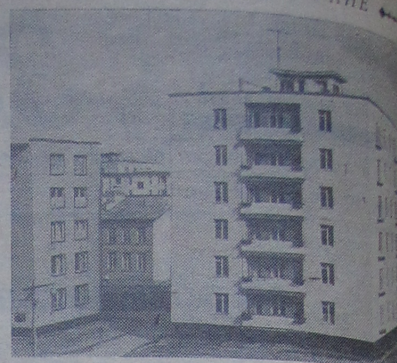
Впервые производство газобетонных деталей и монтаж их жилых домов в Ленинграде были освоены Автокомдомостроительным комбинатом. В настоящее время этот метод строительства получил широкое распространение. Ученые типа таких домов разработаны мастерской № 7 «А» проекта.
