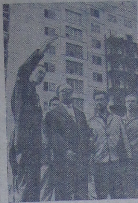
В столице Германской Демократической Республики ведется большое строительство, повсюду поднимаются ввысь многоэтажные дома. Успешно продвигаются работы по созданию нового центра демократического Берлина в районе площади Александерплац. Здесь сооружается крупный массив жилых зданий. На снимке: обер-бургомистр Фридрих Эберт (в центре) осматривает новостройку на улице Сталиналлее. Фото Кристи Хохнедер. Центральбильд
