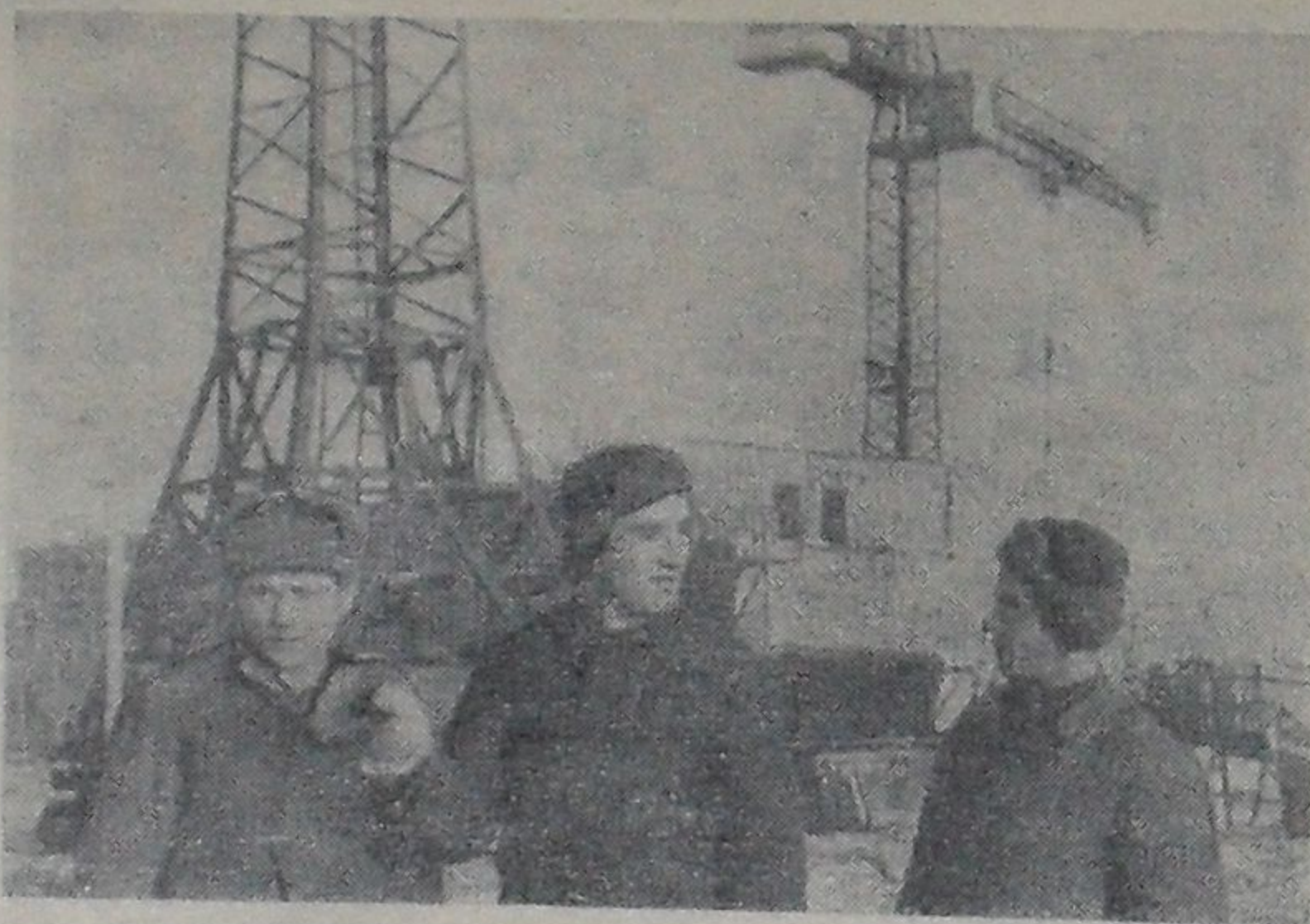
Первой на строительство нового жилого квартала Большой Волги пришла комсомольско-молодежная бригада Геннадия Мудриченко. Уже закончен котлован и укладка фундамента под третий крупнопанельный дом. Сейчас бригада приступает к подсобным работам на четвертом котловане, где будет построена котельная. На снимке: комсомолец Владимир ЯРОВОЙ, бригадир Геннадий МУДРИЧЕНКО и комсомолец Иван КИЩУК. Фото И. Зверева.
