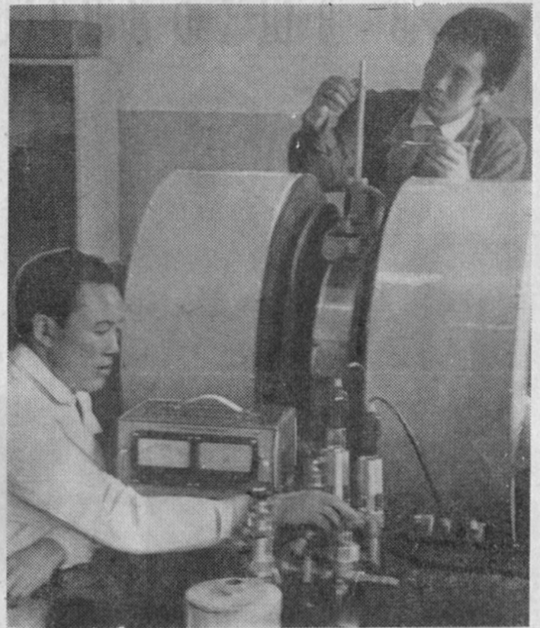
Научный сотрудник Л. Тогтохбаяр (слева) и Л. Дашзэвг, младший научный сотрудник, заняты юстировкой бета-спектрометра.
