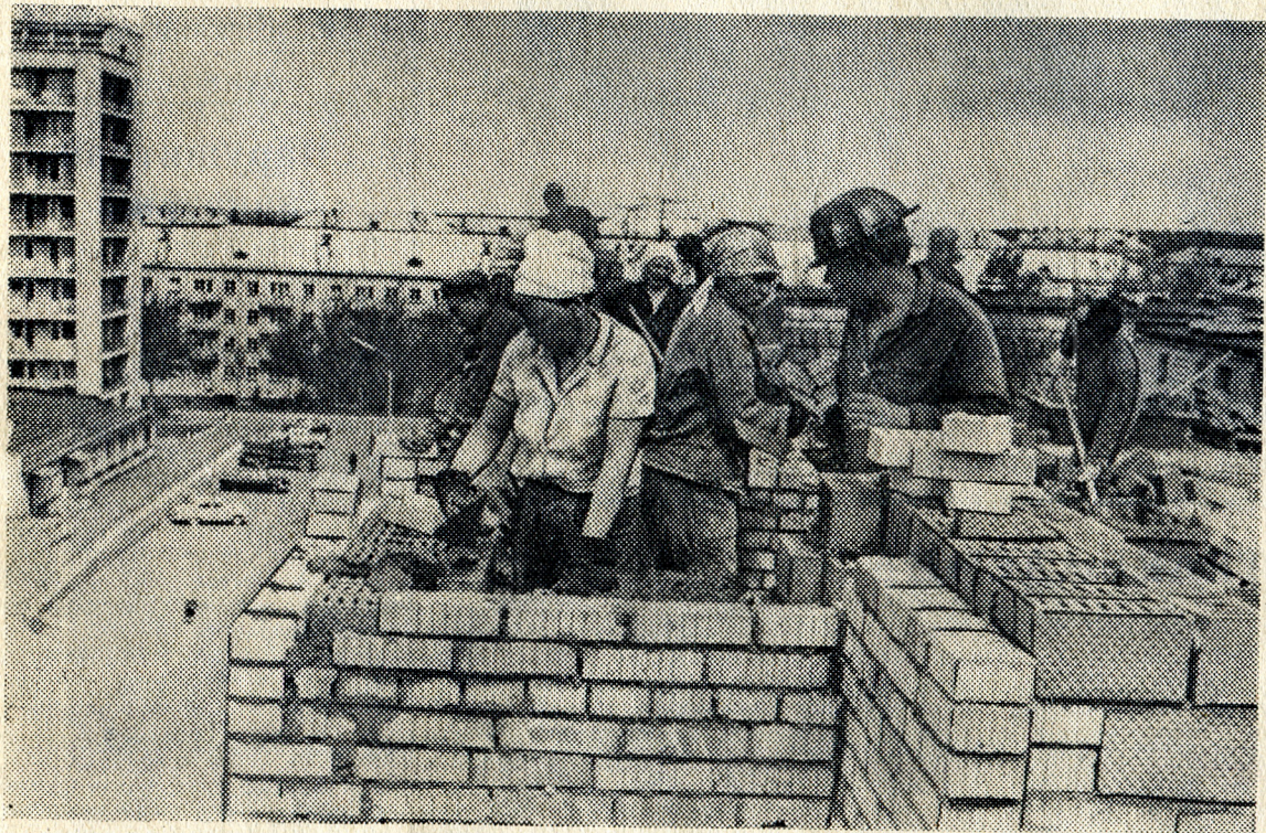
На высоте 7-го этажа выполняют работы (слева направо) каменщики И. Г. Нефедов, Л. Д. Суздальцев, рабочая А. М. Ильина, штукатур Л. С. Богданов и каменщик П. С. Савин.
