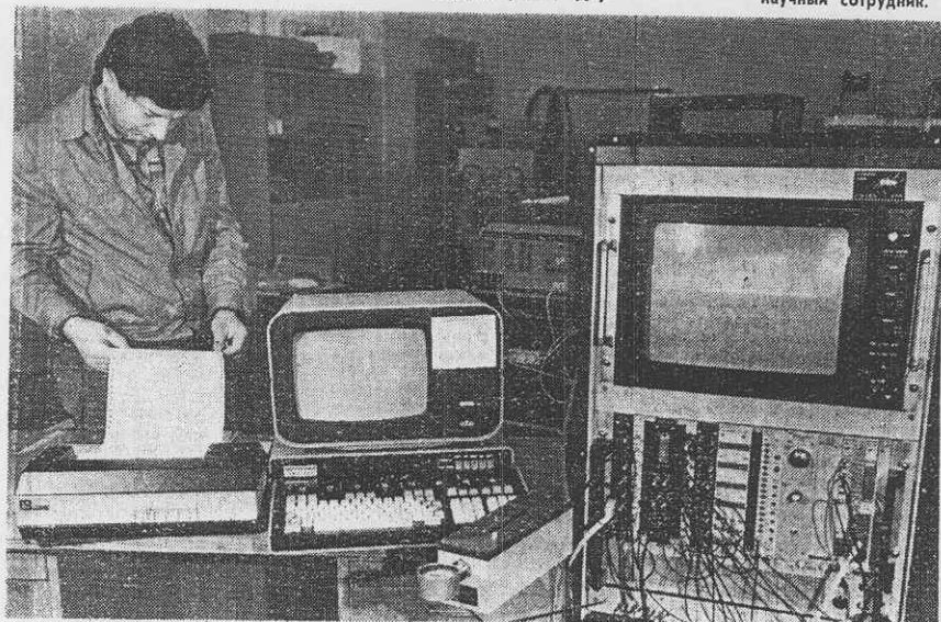
Линейный рентгеновский детектор для исследования структуры кристаллов при сверхвысоких давлениях, созданный в ЛВЗ в 1986 году, налаживает научный сотрудник С. П. Черненко. Фото Н. ПЕЧЕНОВА.
