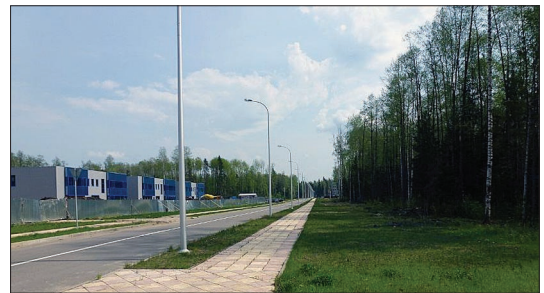
Резиденты ОЭЗ «Дубна» строят свои объекты, имея уже готовую инженерную и транспортную инфраструктуру.
