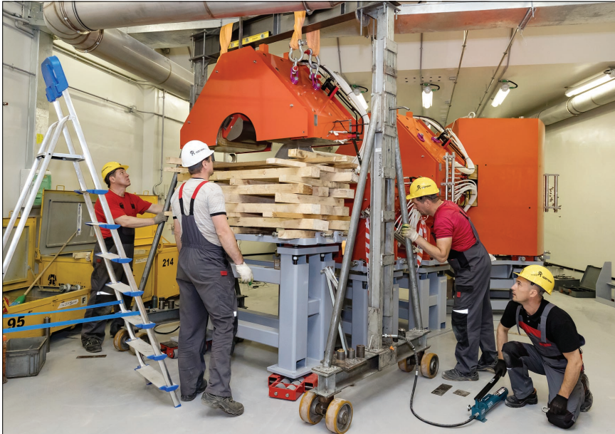
Монтаж газонаполненного сепаратора.
