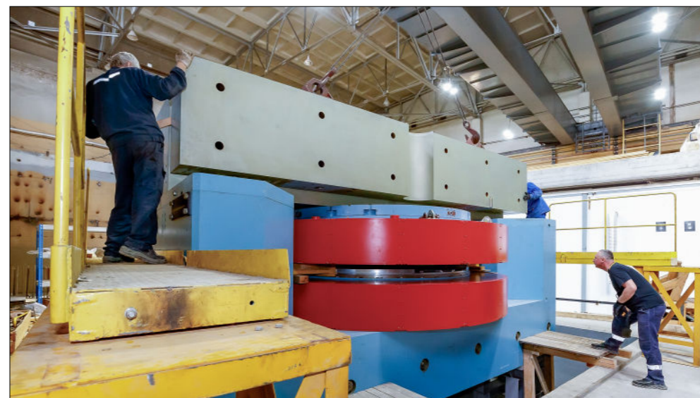
Фото 5. Монтаж последних элементов магнита ДЦ-140 ведут Н. П. Хрустов, А. Н. Быков, А. А. Губанов
