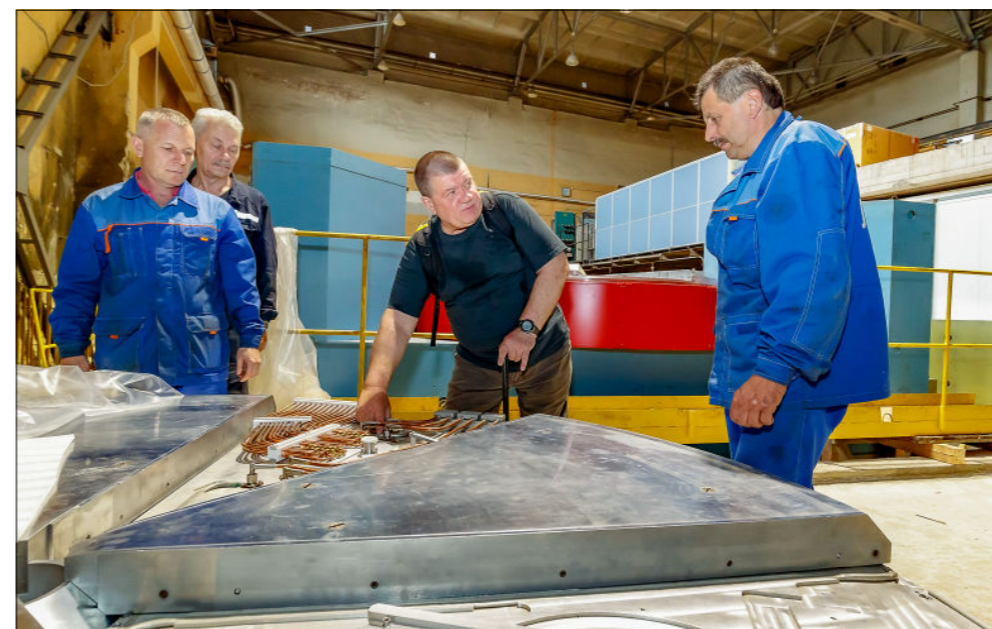
Фото 4. В процессе монтажа магнита ДЦ-140. Слева направо: А. В. Куликов, Н. П. Хрустов, В. Б. Галинский, А. Н. Быков
